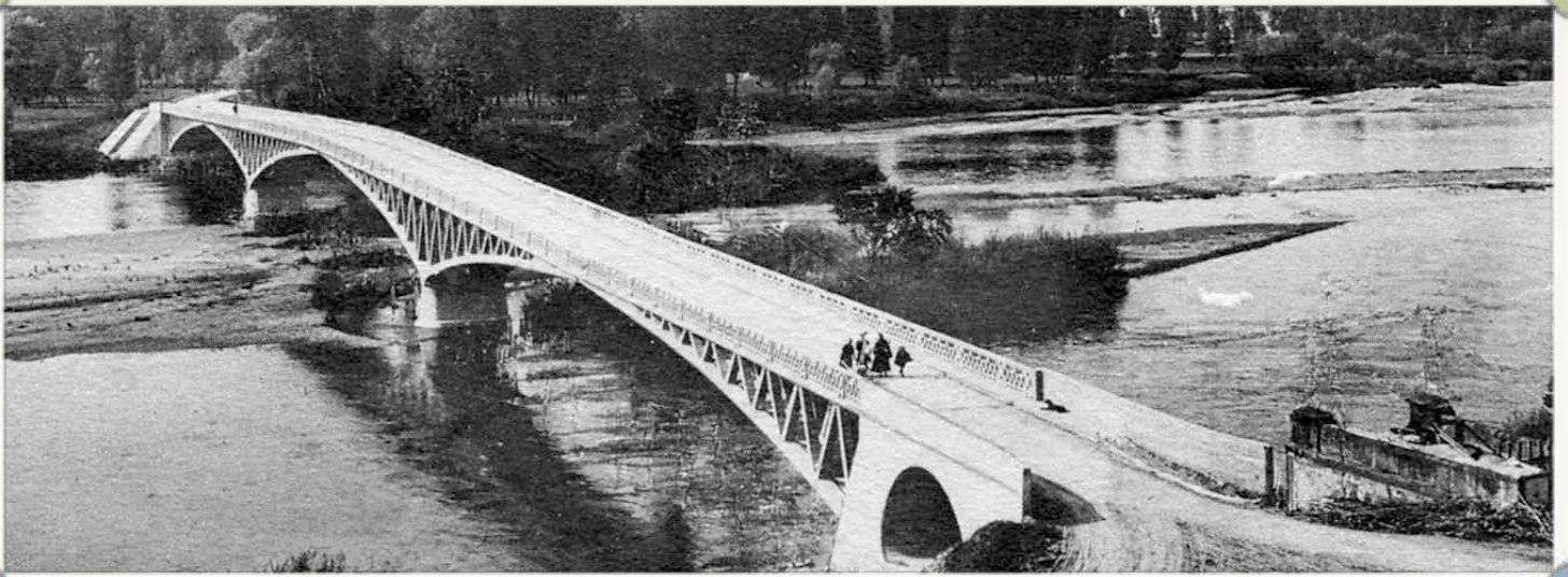
1911 - Pont béton armé (Freysinnet)
